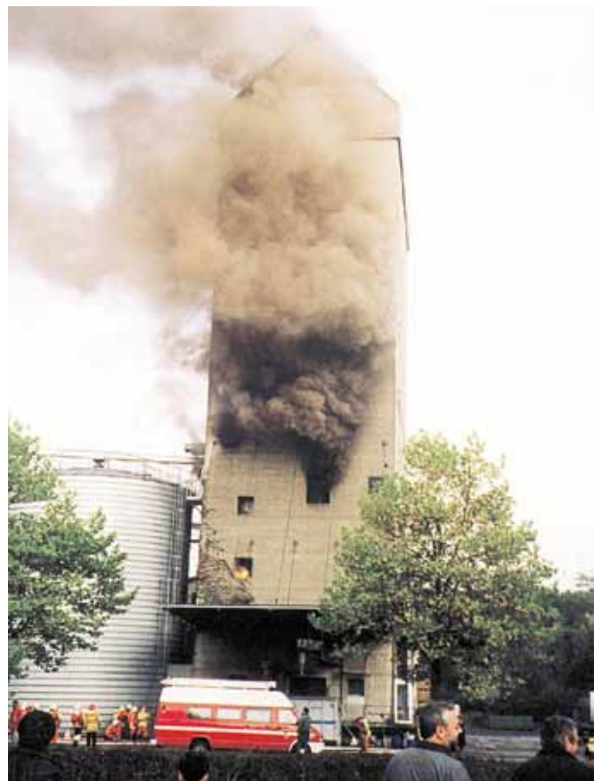
2001 stand die Trocknungsanlage im Getreidesilo in Flammen – es entstand ein Schaden von mehr als 1 Mio. Franken.
