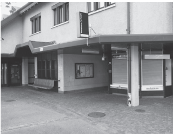
Anschlagkasten bei der Post Herblingen
